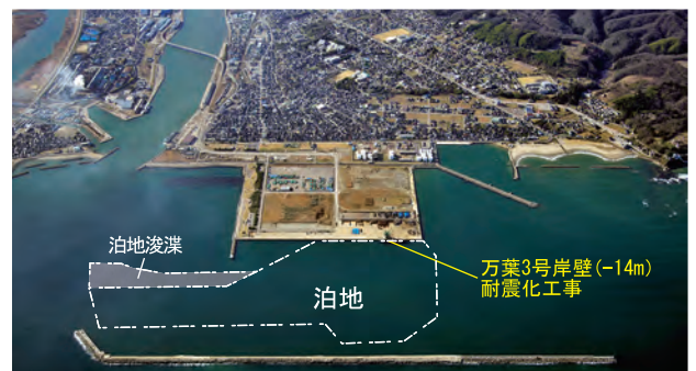
万葉ふ頭3号岸壁(伏木港) 提供: 伏木富山港湾事務所
