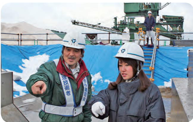
前日の雪が残る中、現場の施工状況を見る山本所長と米島さん
