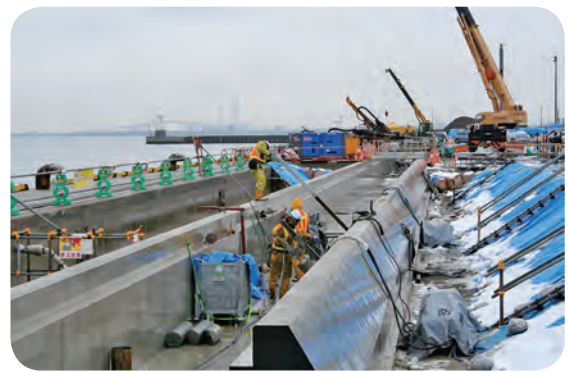
上部工施工状況
