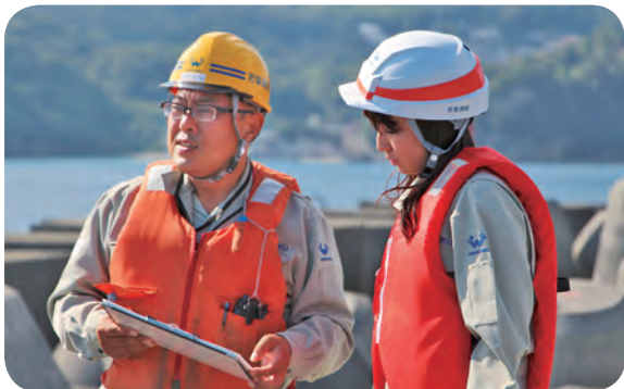
現場で工事概要を説明する北村所長と宮入さん
