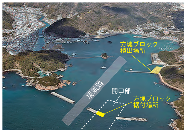
下田港での施工場所
