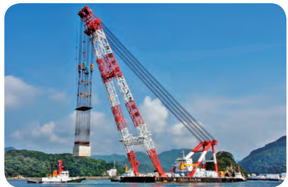
3,000トン級起重機船で方塊ブロックを吊り上げる
