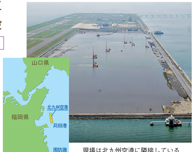
現場は北九州空港に隣接している
