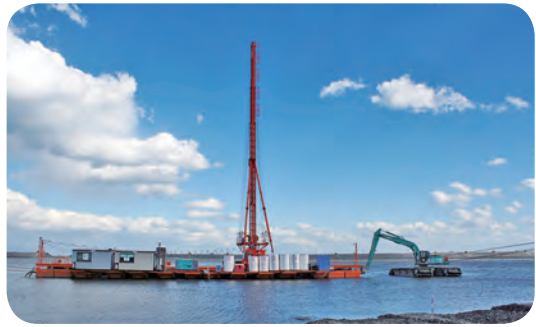
PDF工法の施工現場
