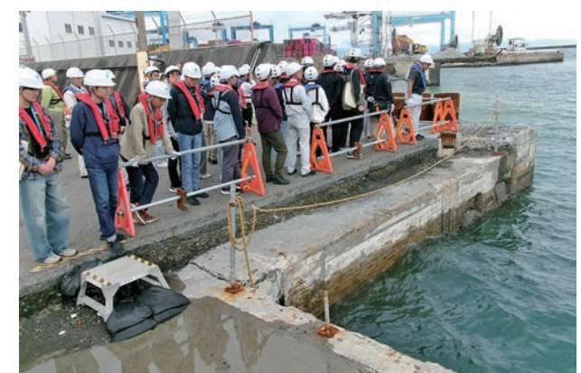
既設構造物が一部撤去された岸壁
