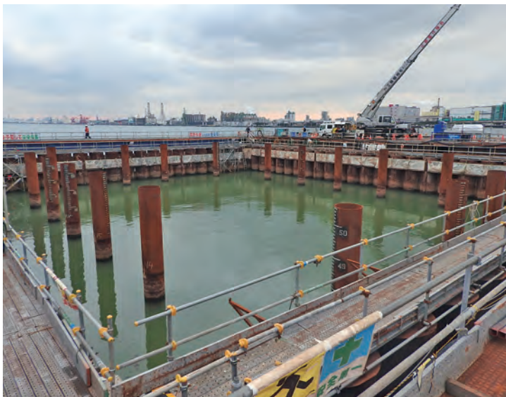
鋼管矢板井筒状内の水中で橋脚基礎工事が進む現場
