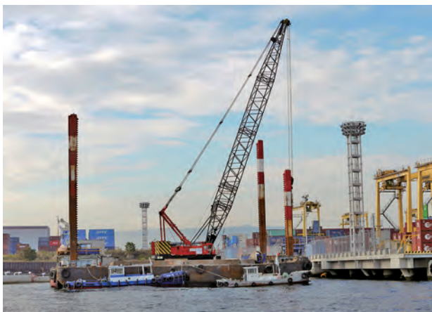
先行掘削が進む現場
