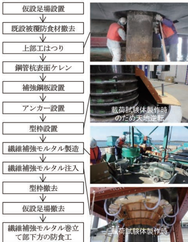
図-6 施工フロー
