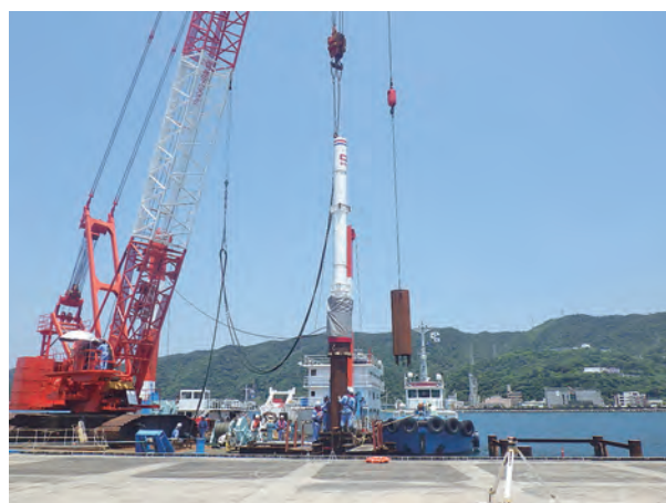
写真-2 ハンマ打撃による杭打ち作業
