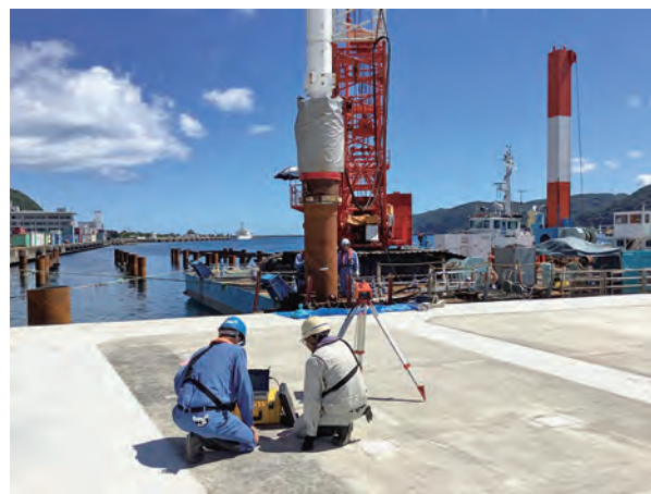
写真-4 PDMによる「非接触」計測状況
