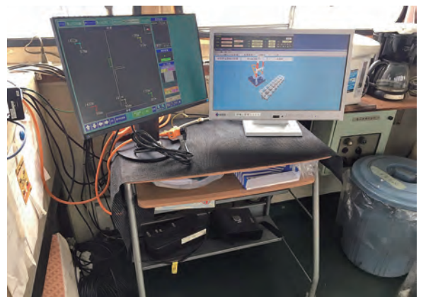
写真-5 ジャケット位置誘導モニタ設置状況
