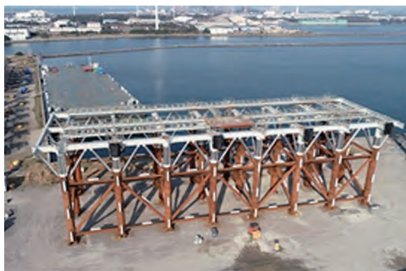
写真-1 ジャケット製作状況
