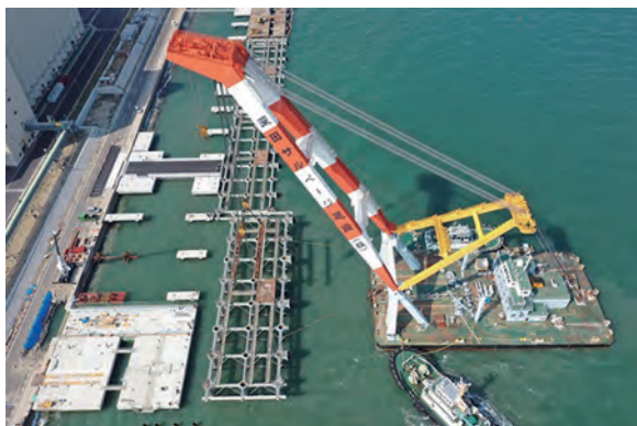
写真-2 ジャケット据え付け状況
