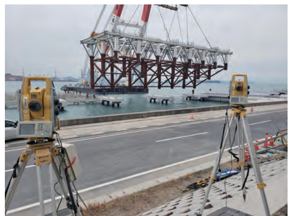
写真-4 ジャケット誘導状況
