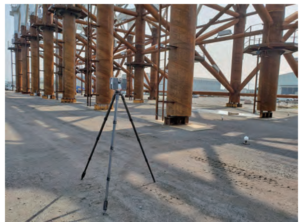
写真-3 3Dスキャナによる計測状況
