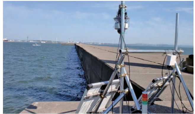
写真-1 現場事例(その1)
