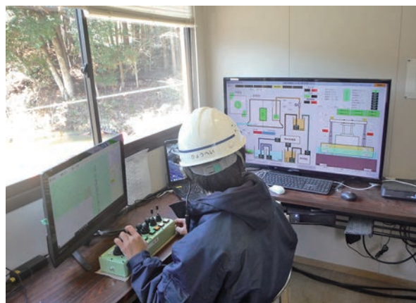
写真-5 管理事務所での遠隔制御状況
