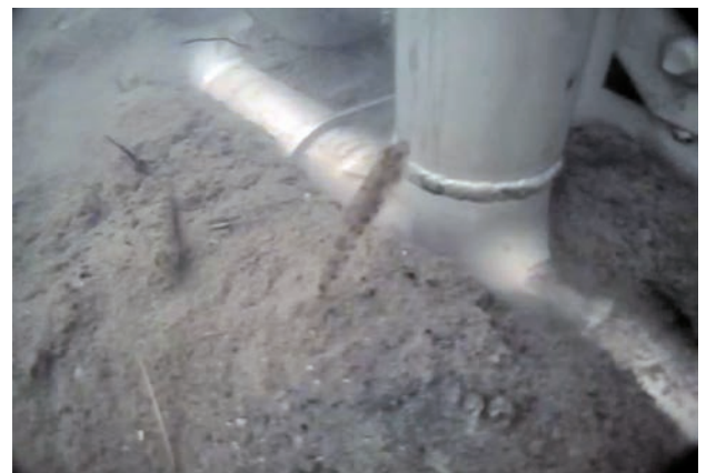
写真-4 浚渫時の水中ロッド周辺の状況
