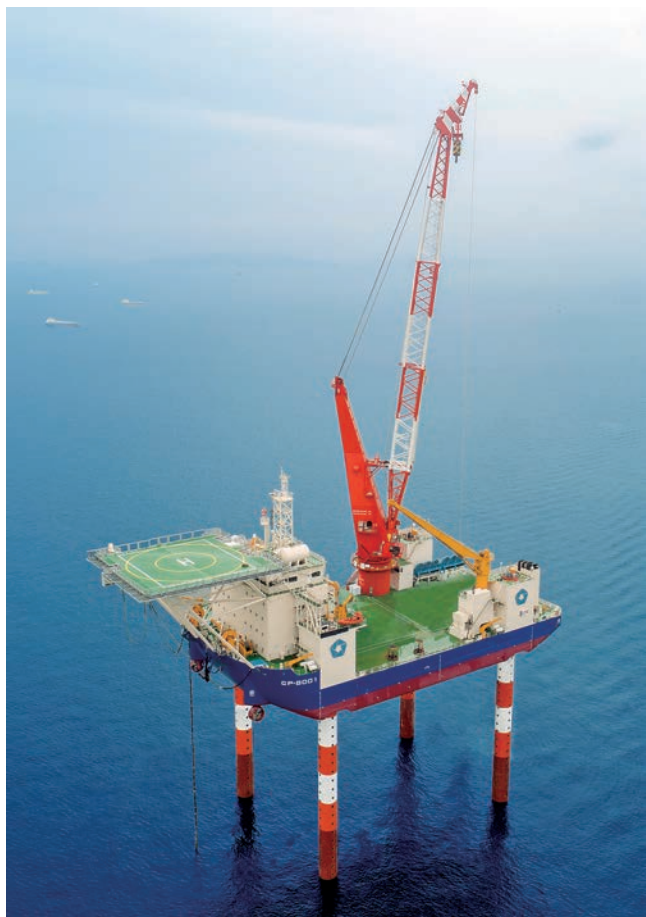
写真-1 ジャッキアップ状況 (最大高さ: 海水面から船底まで 35m)
