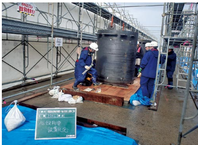
写真-3 プレキャスト受梁製作時の鞘管調整
