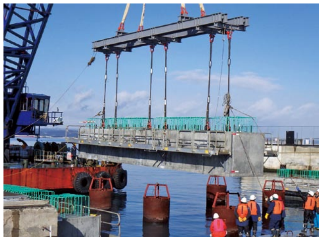
写真-4 専用吊天秤と杭頭鋼製ガイド
