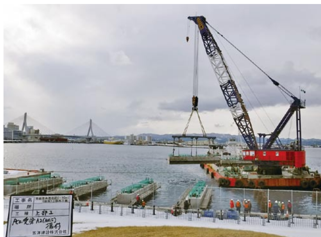
写真-5 プレキャスト受梁据付状況
