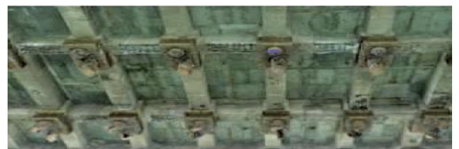
図-4 調査栈橋上部工下面の3Dモデル(一部)
