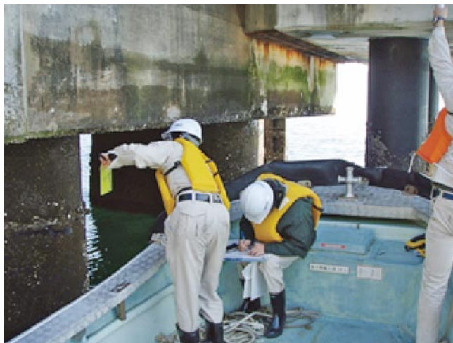
写真-1 一般的な栈橋下面の点検・調査状況
