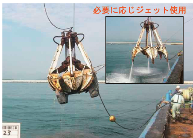
写真-3 障害物の撤去状況
