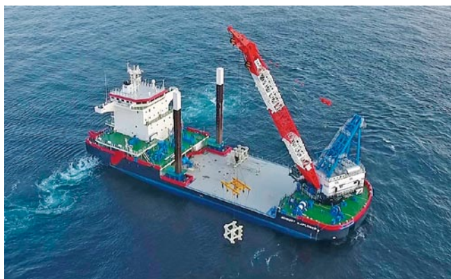
写真-10 魚礁据付状況
