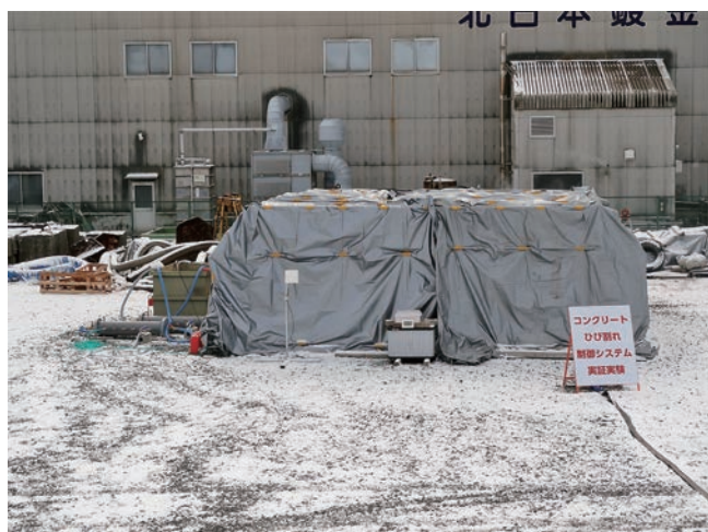
写真-1 実証実験での養生状況全景
