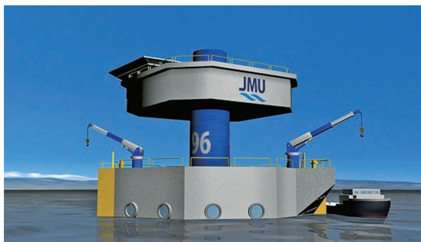
写真-2 浮体式没水型 OTEC(1万kW)日本海事協会より概念承認取得 提供：ジャパンマリユナイテッド株式会社
