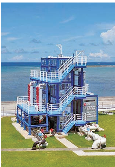
写真-1 沖縄県久米島に設置されている OTEC 実証試験機
