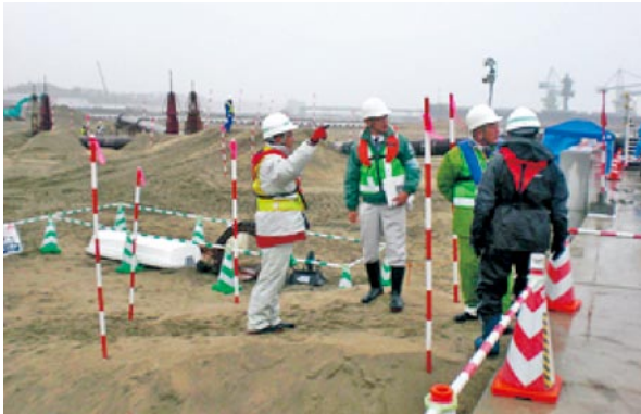
安全通路等確認
