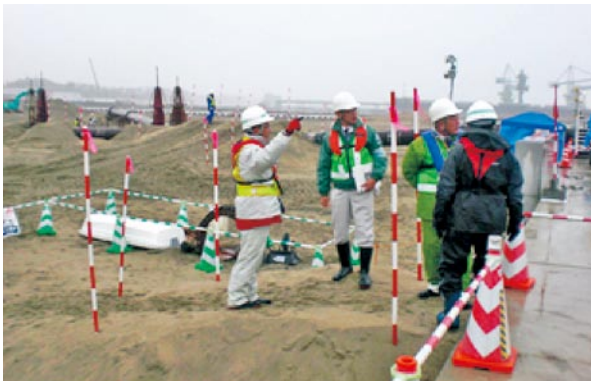
安全通路等確認
