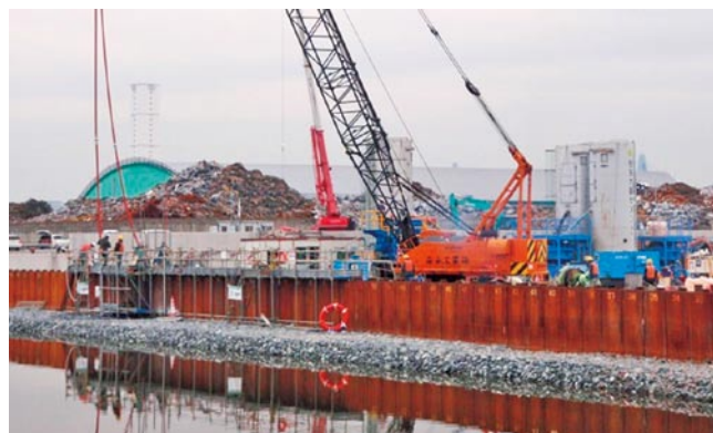
写真-3 施工状況
