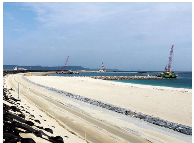
写真-2 人工ビーチの施工状況
