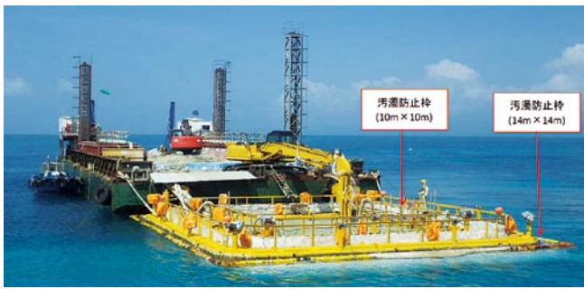
図-4 バックホウ浚渫作業の状況 4)
