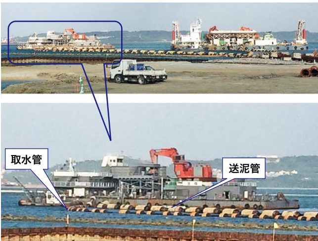
写真-1 空気圧送船による揚土
