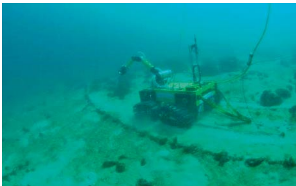
写真-8 海底ケーブル調査状況
