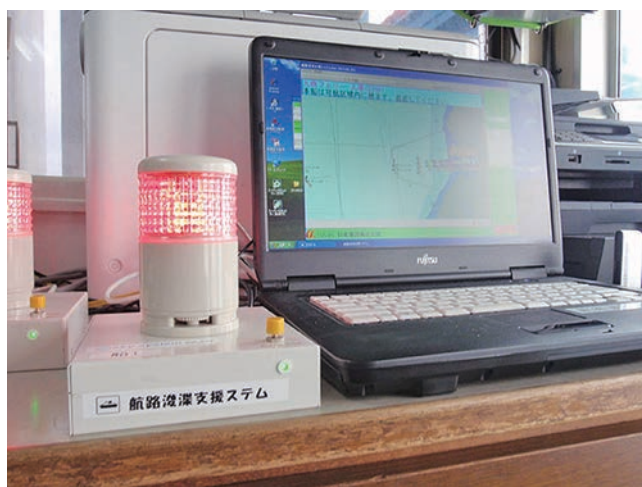
写真-3 システム設置状況 (作業船内)
