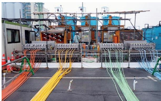
写真-2 施工状況(注入プラント)
