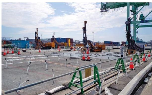
写真-1 施工状況(削孔)
