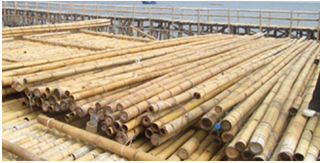
写真-2 竹杭の製作状況
