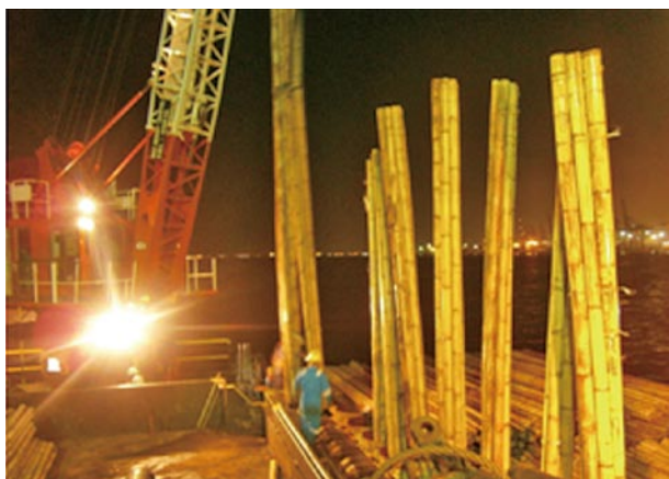
写真-4 竹杭の打設状況
