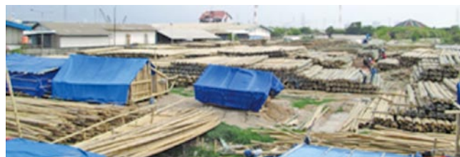
写真-5 竹杭のストック状況
