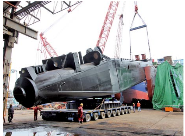
写真-5 大型カッターラダー取付状況
