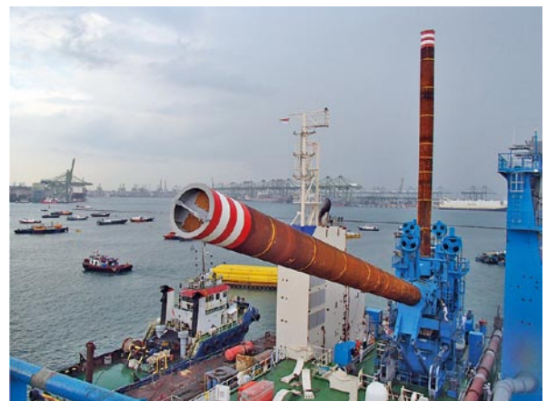
写真-7 スパッド起伏状況
