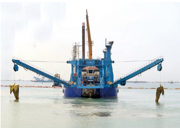
写真-4 アンカー打替状況
