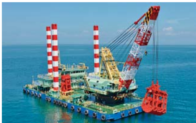
写真-1 「若鷲丸」全景
