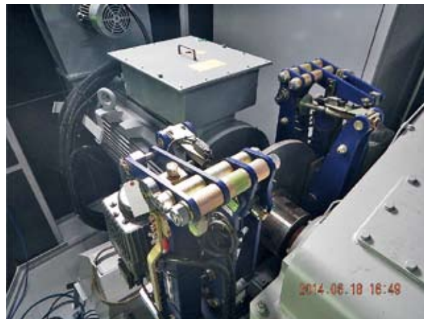
写真-3 モーター兼発電機
