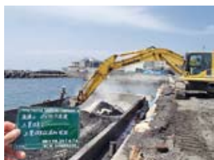
写真-14 土砂の改良状況
