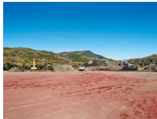
写真-13 土砂の運搬場所(島内)
