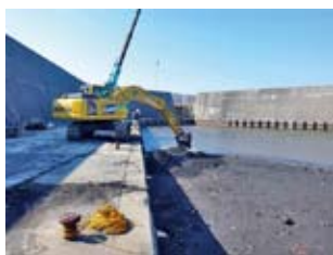
写真-9 陸上バックホウの掘削状況
