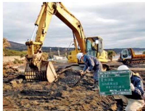
写真-12 土砂分別の作業状況
