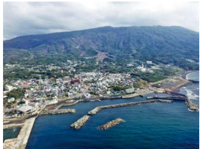
写真-1 大島町元町地区の被災状況
