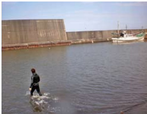
写真-2 元町漁港内の土砂の流入、堆積状況
