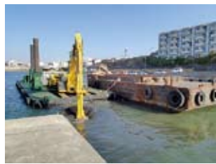
写真-10 バックホウ浚渫船の掘削状況
