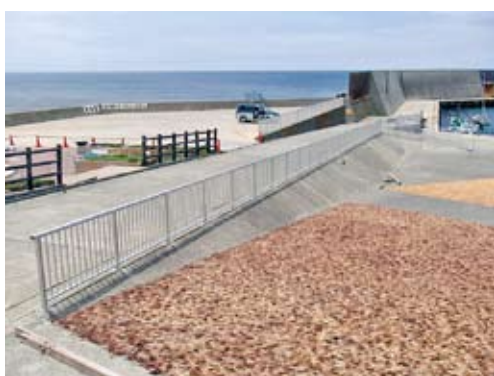
写真-18 隣接施設の復旧状況(転落防止柵)
