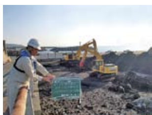
写真-17 流木の分別状況
