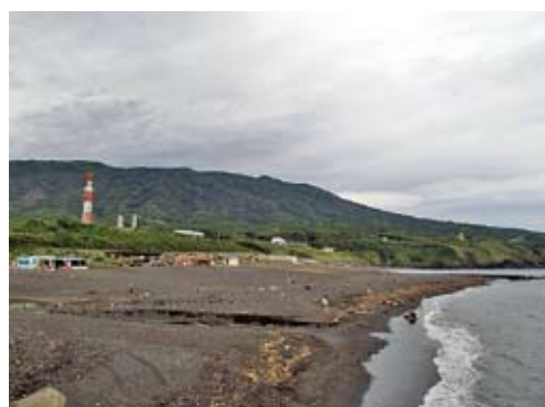
写真-20 弘法浜現況(海開き後)
