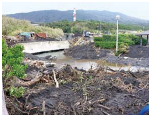
写真-6 隣接施設(環境整備用地)の被災状況
