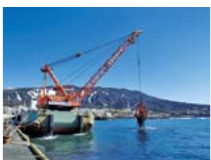
写真-16 流木の撤去状況
