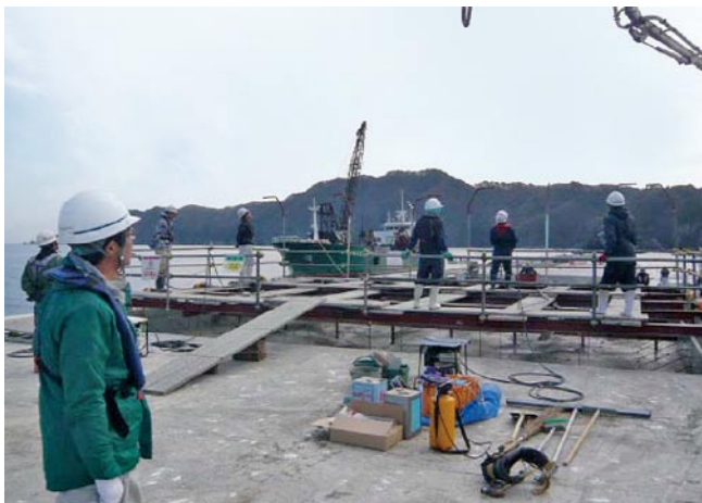
写真-1 本部・支部パトロールの状況(神戸港)
