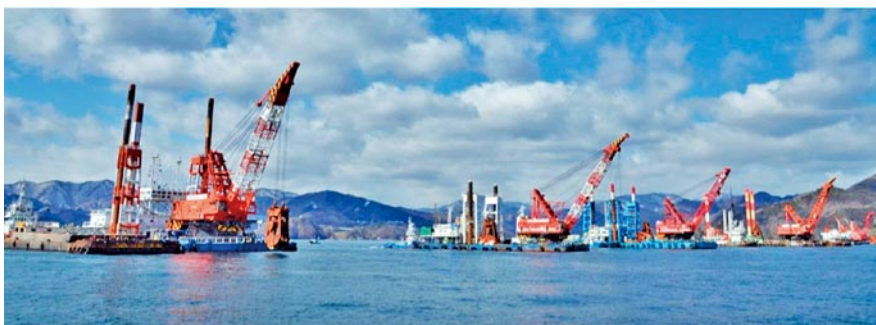
写真-1 ケーソン取り壊し状況(①、②工事)
