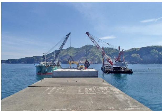
写真-5 ケーソンの中詰め状況(①工事)
