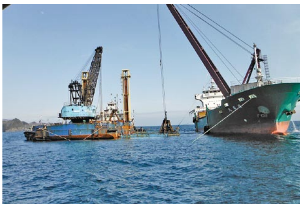
写真-4 汚濁防止柵を使用しての基礎捨石工(⑤工事)
