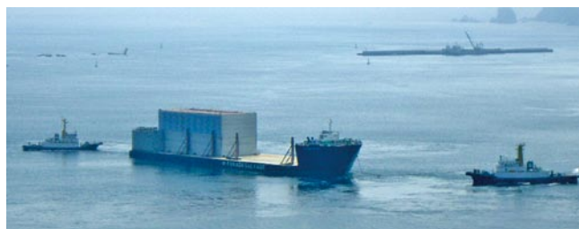
写真-2 釜石港に到着したハイブリッドケーソン
