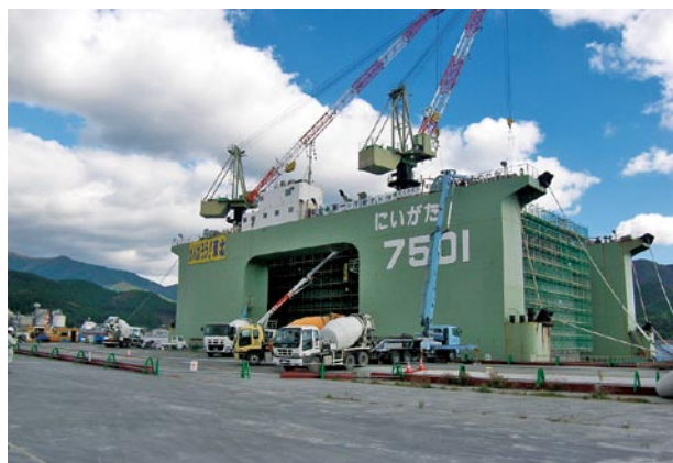
写真-6 ケーソンの製作状況(②工事)
