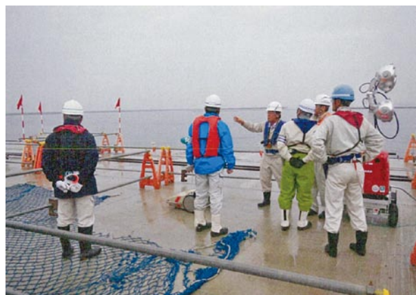
写真-3 防波堤上パトロール状況（茨城港常陸那珂港区）
