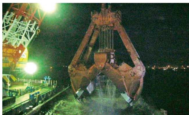
写真-4 夜間の航路泊地浚渫 (⑥工事) 状況
