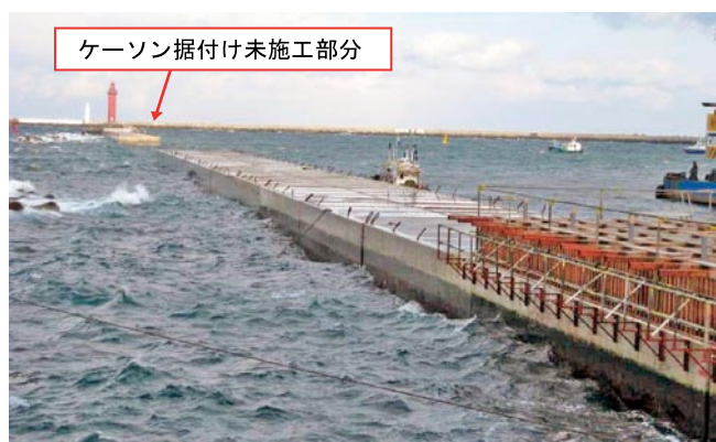
写真-2 北防波堤上よりハネ部縁端を望む (④工事)
