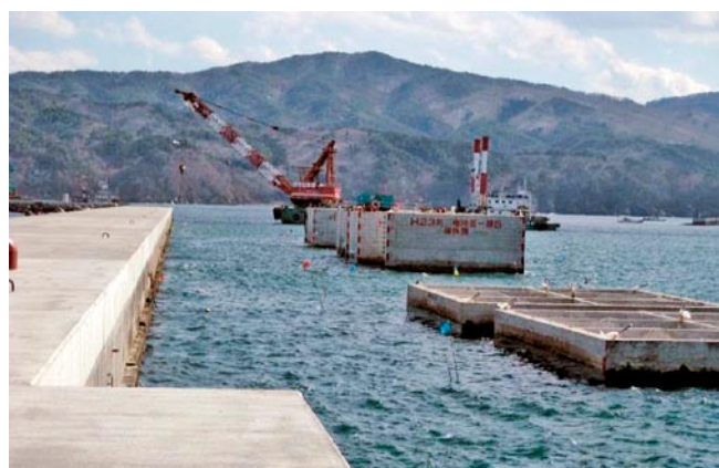
写真-9 嵩上げが終了した藤原防波堤と、その背後に仮置きされた竜神崎防波堤用ケーソン
