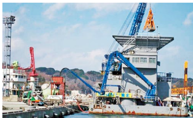
写真-10 コンクリート供給不足を補うために投入されたコンクリートプラント船
