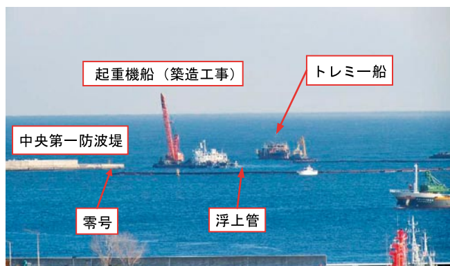
写真-3 外港地区開口部の施工 (③⑤工事) 状況
