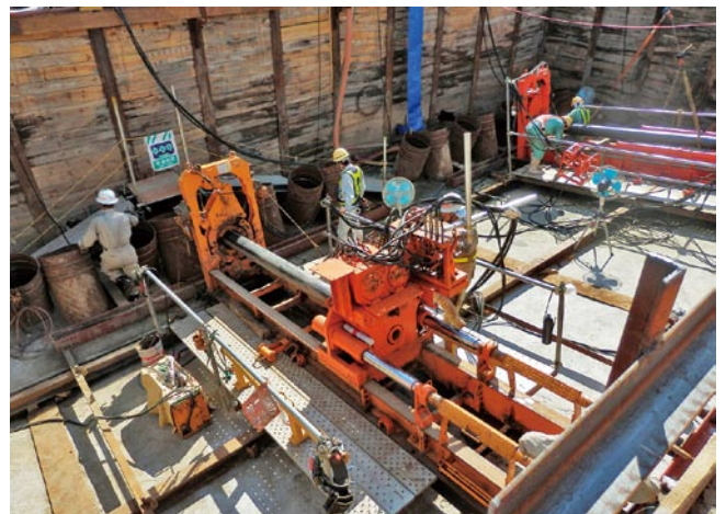
写真-5 2段タイ材埋設管の小口径推進状況
