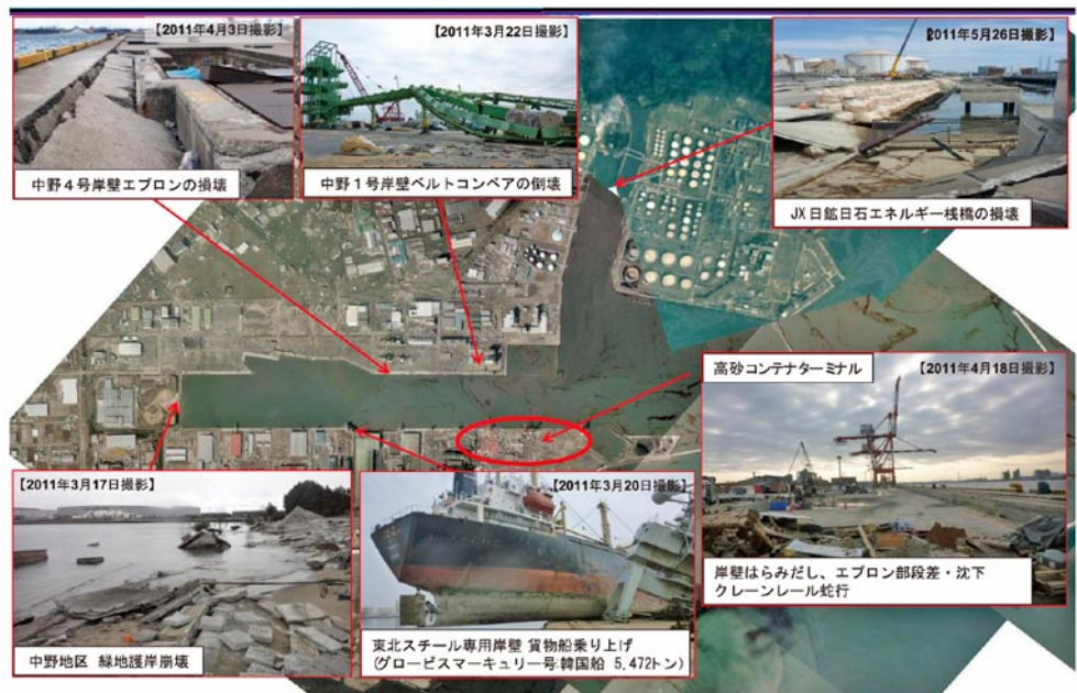
写真-1 仙台港区の被災状況 (係留施設)
