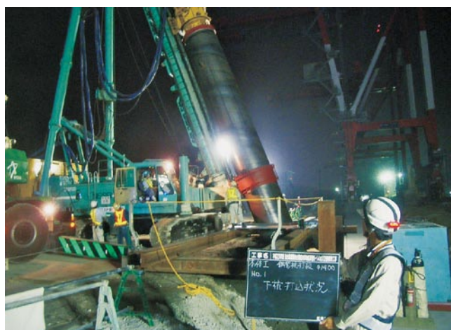
写真-3 鋼管杭打設状況(夜間作業)
