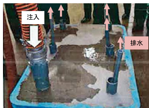
図-9 注入状況（水中不分離性モルタル）
