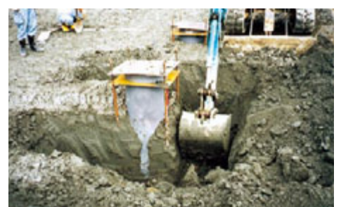
処理土地盤(大型サンプリング状況)
