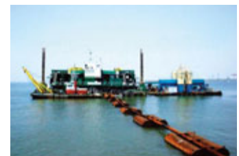
空気圧送船、固化材供給船
