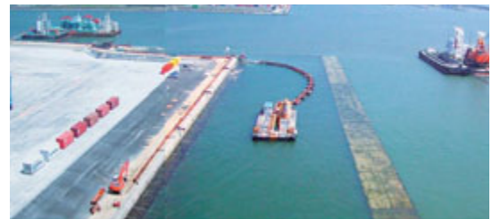
護岸背面裏込め施工全景
