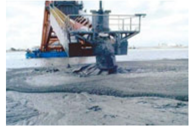
処理土打込み状況
