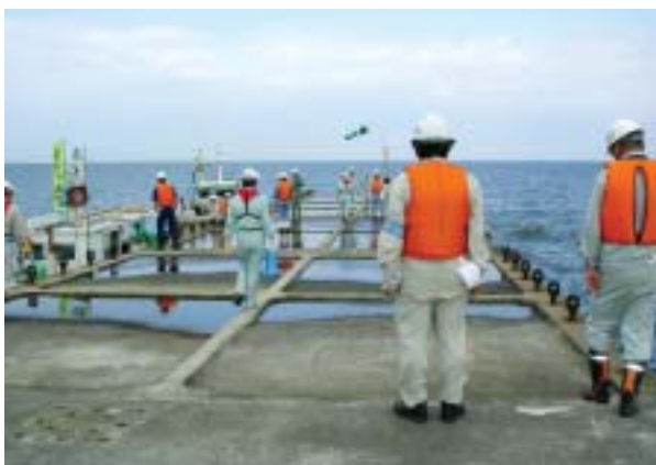
四日市港霞外港地区防波堤（霞）築造工事
